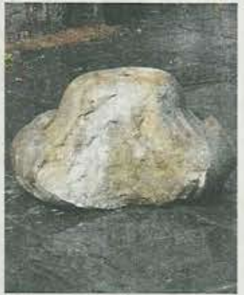
El ornamento desprendido.
